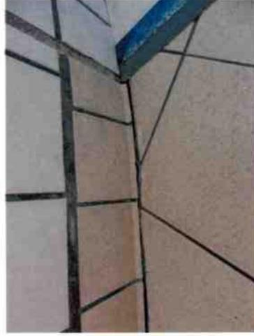
Je relève l'absence de joints au carrelage côté bien-être, ainsi que sur le relevé : 2
