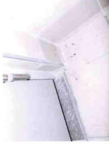
Au niveau de la sortie « collectif », derrière la porte d'accès au bassin, je relève des traces de rouille importantes sur le carrelage au sol : 1 photo
