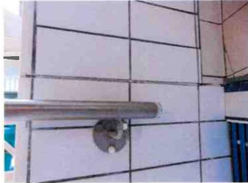
Je relève la présence d'une dégradation et d'un gonflement au carrelage, à l'entrée du pèdiluve côté droit : 1 photographie :
