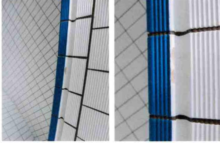
Je constate que l'entourage du jacuzzi est fissuré, avec des traces de rouille visibles : 2
