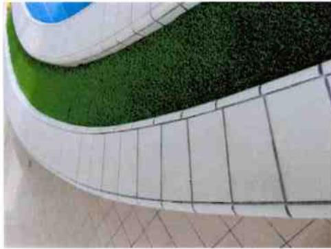
Je relève une dégradation de la baguette du carrelage, côté accès bassin nordique. : 1
