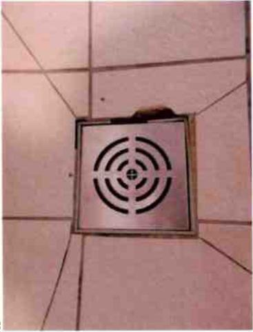
A l'angle, je relève que le carrelage est fendu et l'absence de joints à la périphérie, à la jonction du sol et des murs : 1 photographie :
