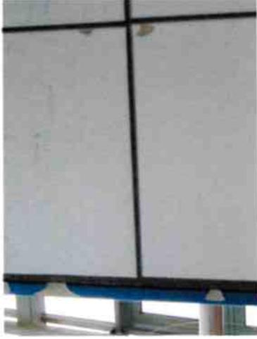
Je relève l'absence de joints au carrelage sur la remontée côté extérieur : 1
